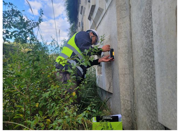
경사계를 이용한 경사도 측정사진
