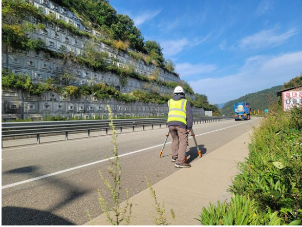
광파기를 이용한 측량 작업사진
